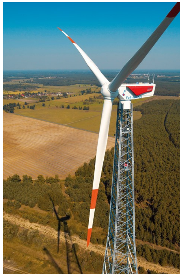
Příhradová konstrukce stožáru [7]
