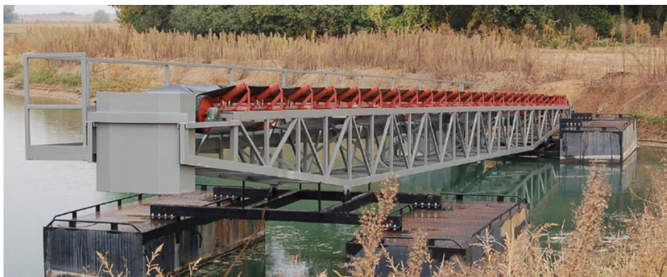
Příhradová konstrukce dopravníku [5]
