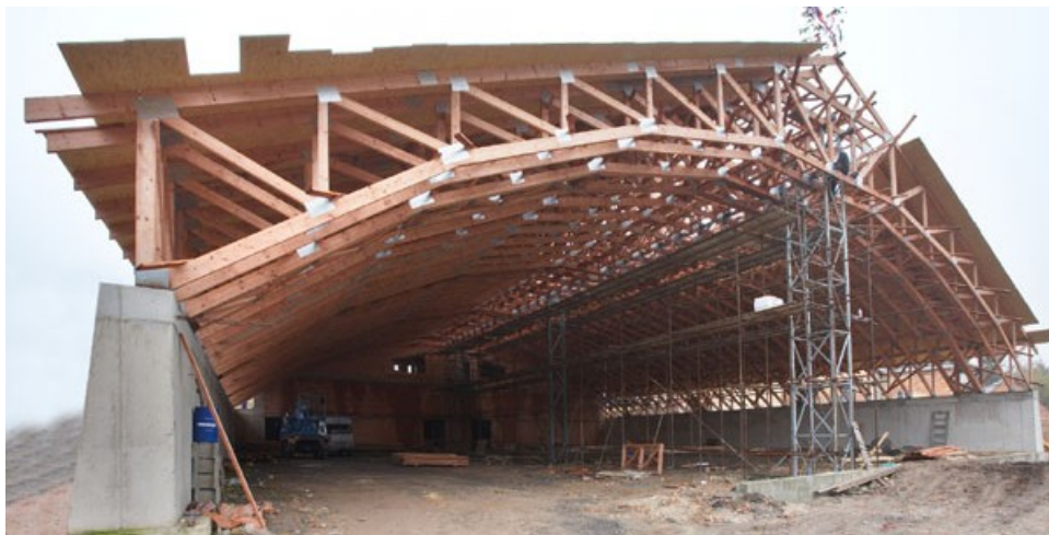
Příhradová konstrukce zastřešení [6]
