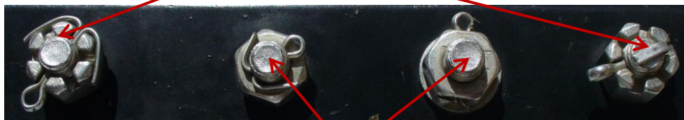
Pojištění závlačkou
